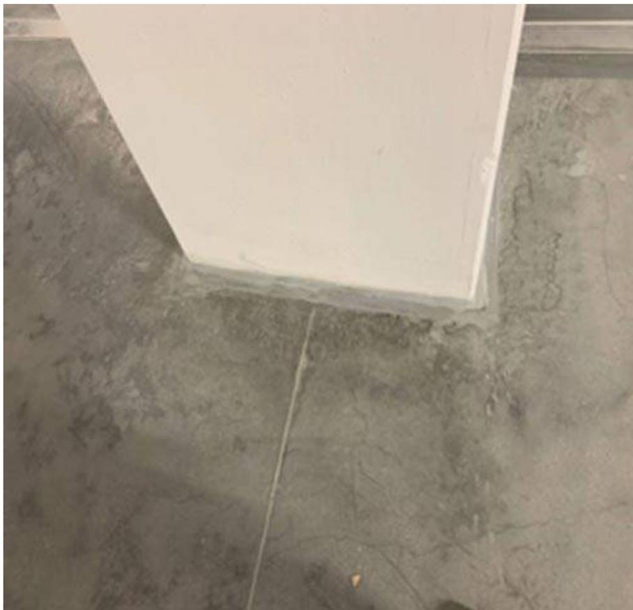
*Per le colonne è stato utilizzato calcestruzzo a basso ritiro e ridotto rinforzo strutturale*
